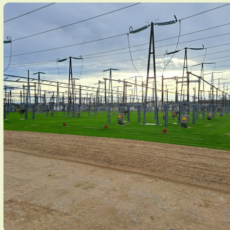
↑ Hydro-ensemencement à proximité des postes électriques, France
